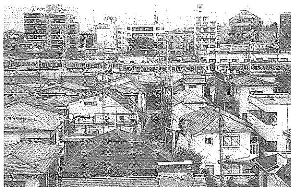
児ヶ谷地区の変貌 北側、高井戸との境の京王線は高架となる
