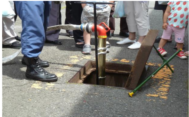
スタンドパイプのセットの様子
